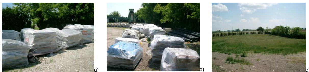
Slika 5.: Odloženi azbestni otpad na odlagalištu za neopasni otpad „Totovec“ i buduća lokacija posebne plohe za azbest u okviru odlagališta
