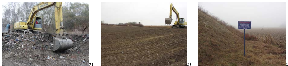
Slika 18.: Sanacija površine onečišćene otpadom na lokaciji „Jacine“
