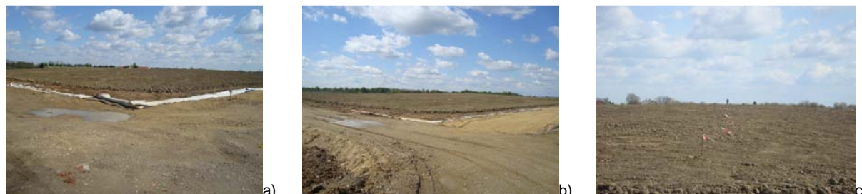
Slika 16.: Sanacija površine onečišćene otpadom na lokaciji „Gorice“
